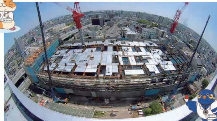
JCHO中京病院：建替え工事（2024.8）
