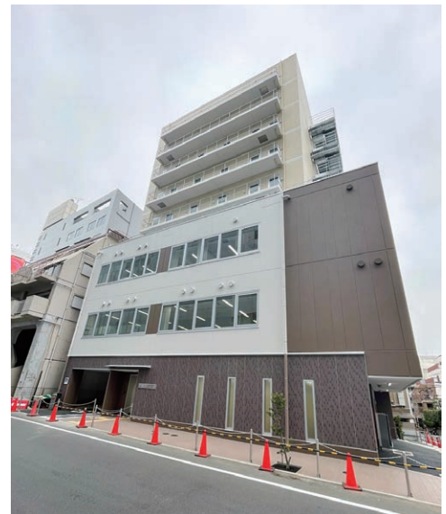
研修センター外観 正面
