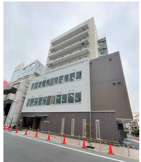
研修センター外観 正面
