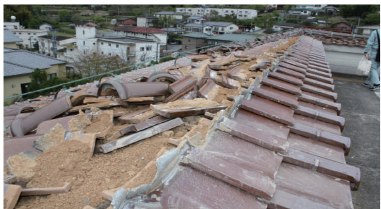
壊れた屋根瓦
