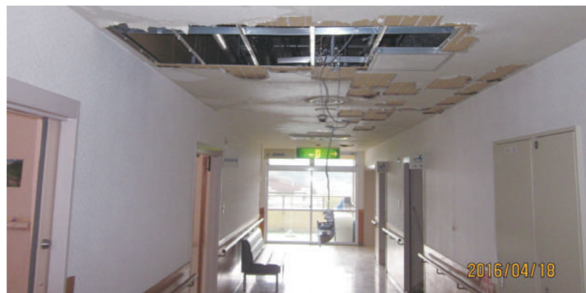
漏水被害のあった東棟
