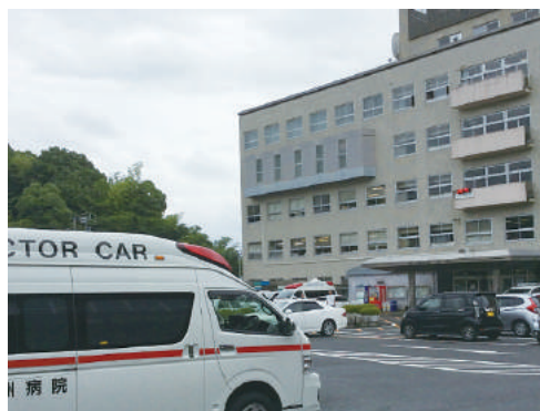
朝倉市役所（現地災害対策本部）
