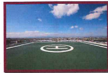
屋上ヘリポート
